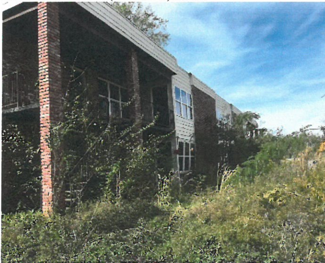
12 CENTER PL N (BLDG 20) 35204
